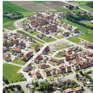
Heulebrug, Knokke-Heist, Belgique / Belgium
