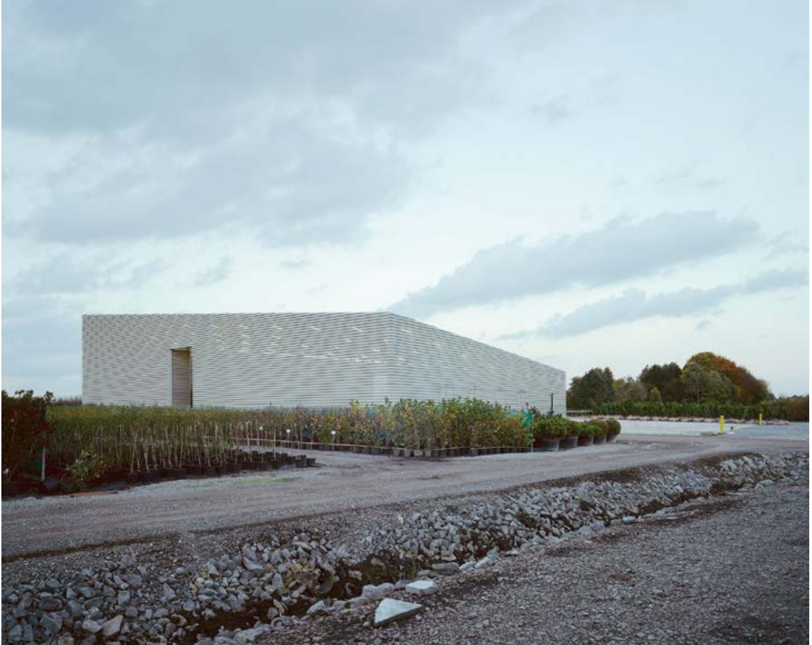
Hall de séchage de plantes en pot, Herselt, Belgique / Drying hall for potted plants Herselt, Belgium
