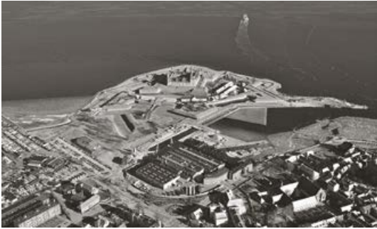
Musée Maritime Danois (avant et après) réhabilitation, Helsingør, Danemark
