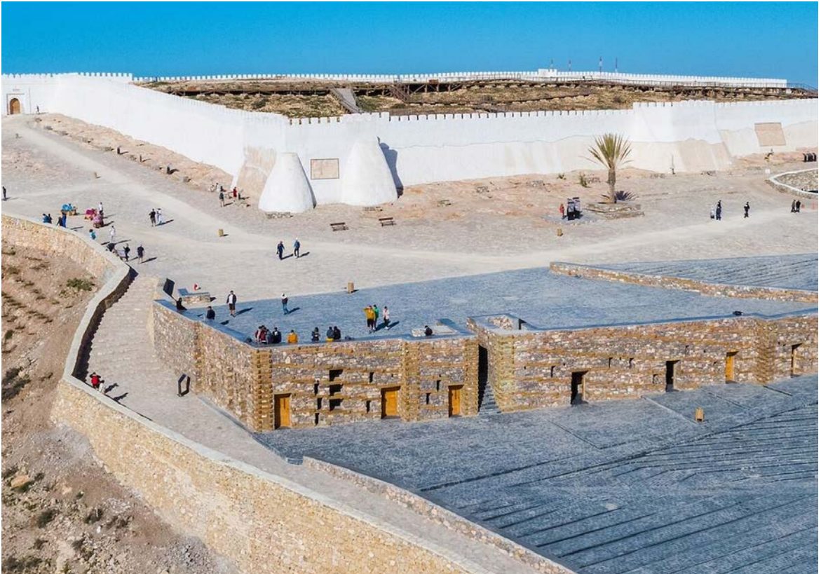
Citadelle d'Agadir Oufella après restauration / Agadir Oufella Citadel after restoration
