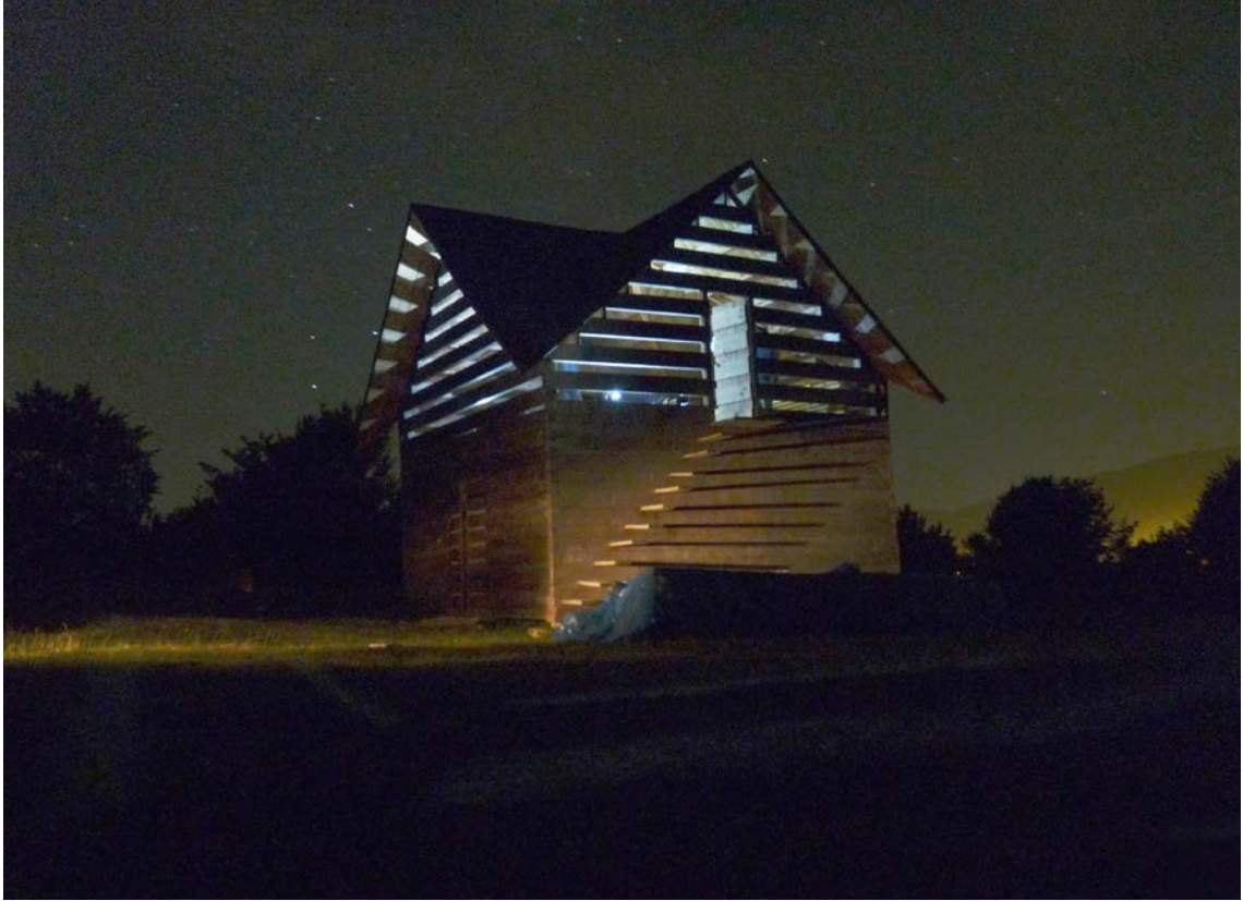
Abri pour cavaliers, construction en rondins de bois / horsemen shelter, blockbau
