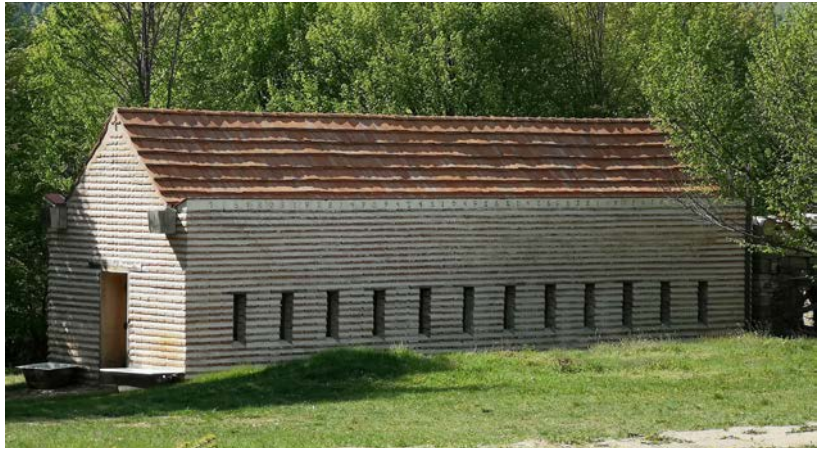
Réfectoire : briques faites à la main, maçonnerie portante / refectory: handmade bricks, load-bearing masonry
