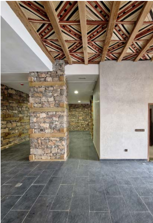
Maçonnerie en pierre sèche et bois, plafonds en lauriers teints au chaudron montés sur bois de palmier / dry stone and wood masonry, cauldron-dyed laurel ceilings mounted on palm wood
