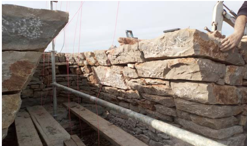
Construction de la voûte en encorbellement / construction of the corbelled vault
