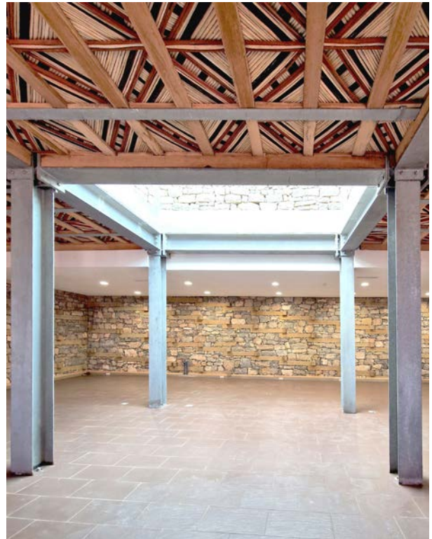
Maçonnerie en pierre sèche et bois, plafonds en lauriers teints au chaudron montés sur bois de palmier / dry stone and wood masonry, cauldron-dyed laurel ceilings mounted on palm wood
