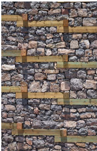
Appareillage d'assises en bois et pierre sèche / wooden and dry stone bonding
