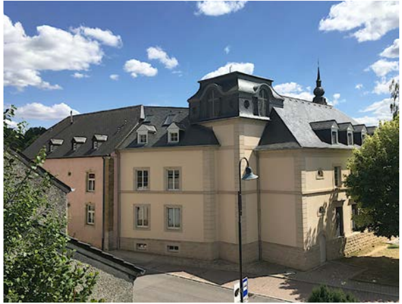
Mairie de Koerich après les travaux / Koerich town hall after the works
