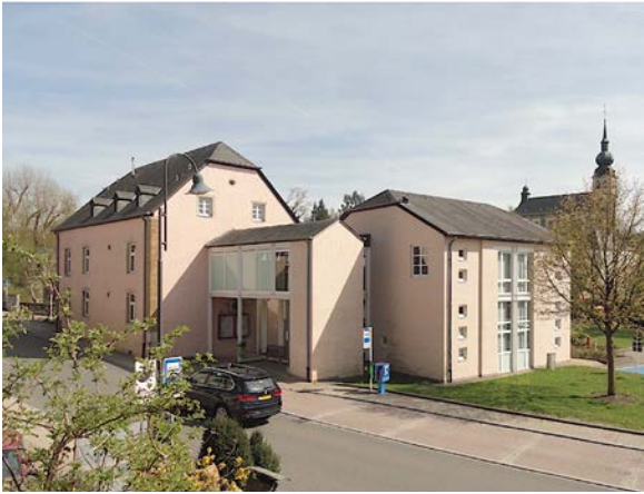
Mairie de Koerich avant les travaux / Koerich town hall before the works
