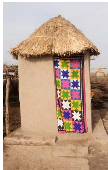
Toilettes sèches / dry toilets
