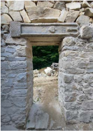
Maçonnerie traditionnelle / traditional masonry
