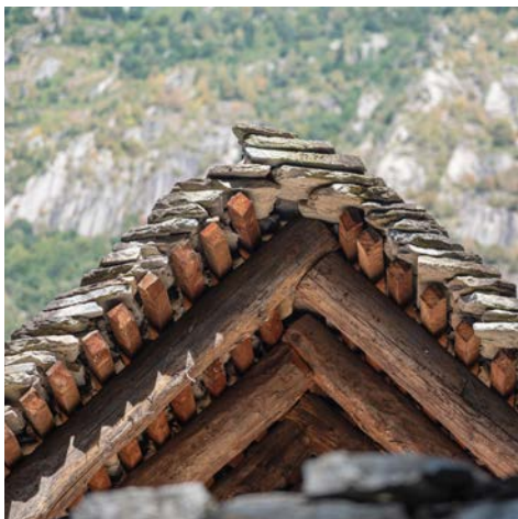
Nouvelle toiture traditionnelle en pierre / new traditional stone roof
