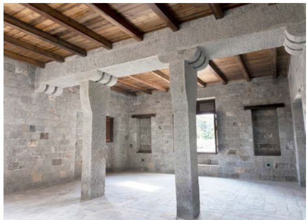
Structure en granit de la salle de réception / granite structure in the reception room
