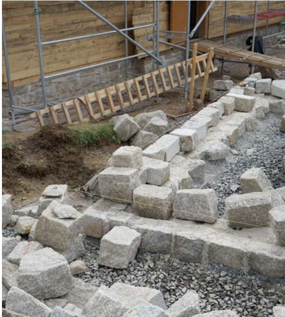
Fondations en béton de chaux / lime concrete foundations
